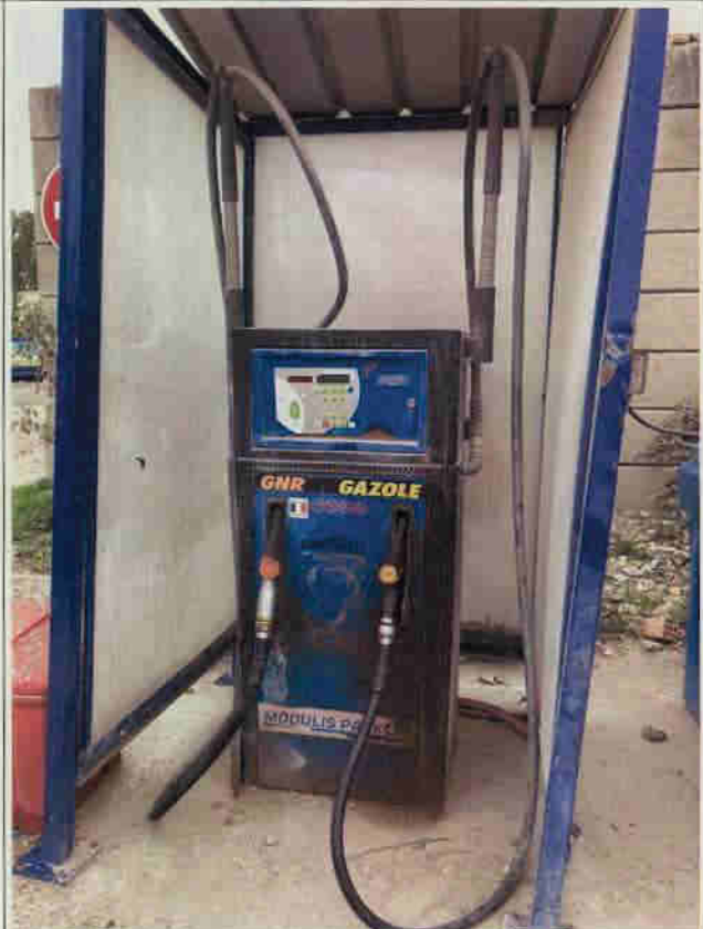
Poste de distribution de gazole et GNR : Absence d'un dispositif d'arrêt d'urgence
